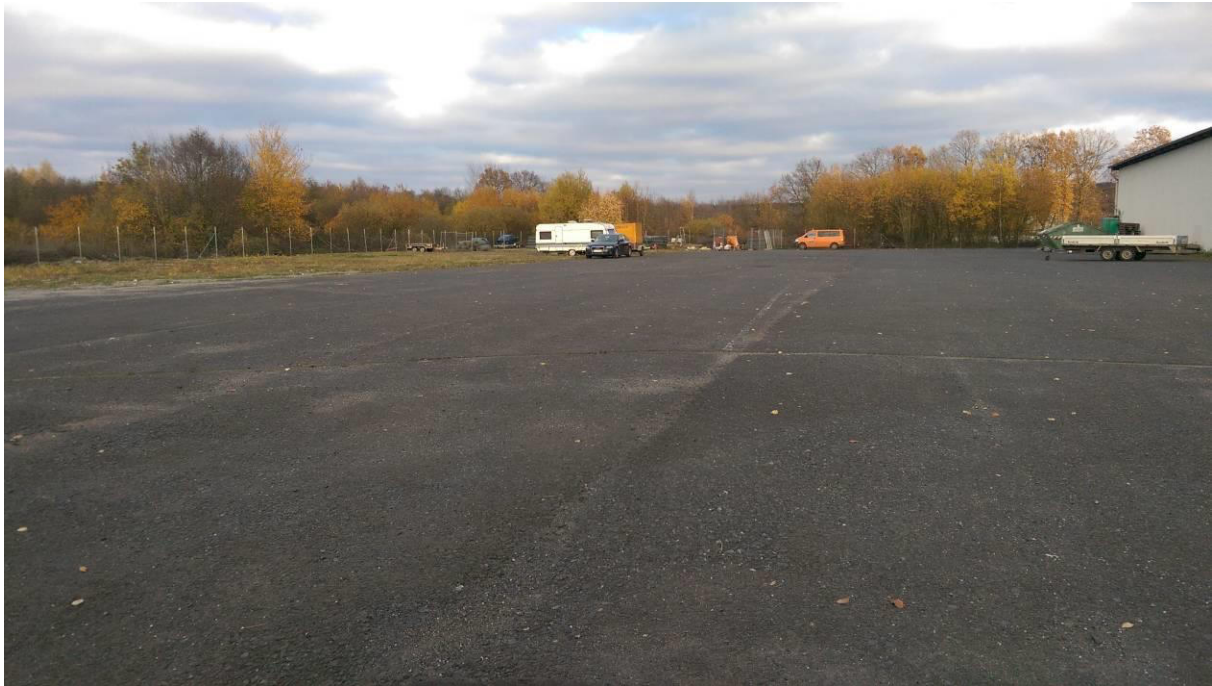
Foto 4: Gewerbeflächen mit Parkplätzen und Lagerflächen
